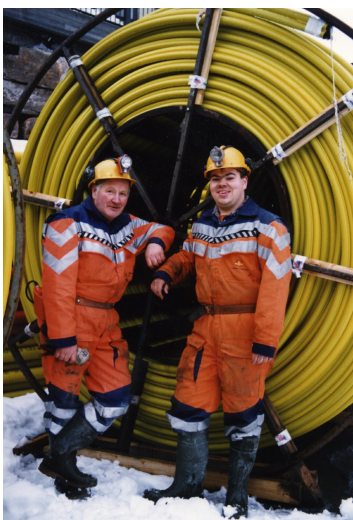
Figur 3: Trekkerør på trommel. Foto Charlotte V. Nielsen
