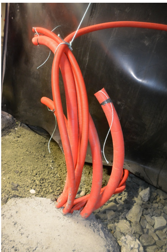
Trekkerør i bankett. Foto: Tore Paulsen
