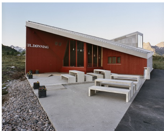
Figur 3: Eksempel på toalettanlegg i privat bygg
