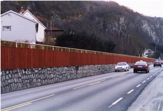
Figur 7: Skjerm med bruksområde støyskjerm
