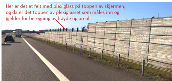
Figur 4: Skjerm med høydesprang
