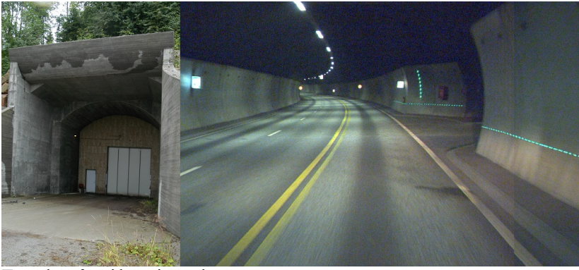
Tverrslag på utsida og i tunnel
