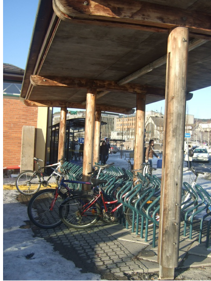
Sykelstativ under tak. Foto: Randi Katharina Øverland
