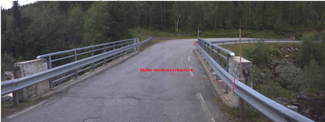
Rekkverk på/ved bru. Foto: Statens vegvesen
