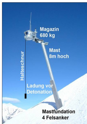
Figur 3: Skredutløsning med Wyssentårn. Foto: Wyssen avalanche control AG
