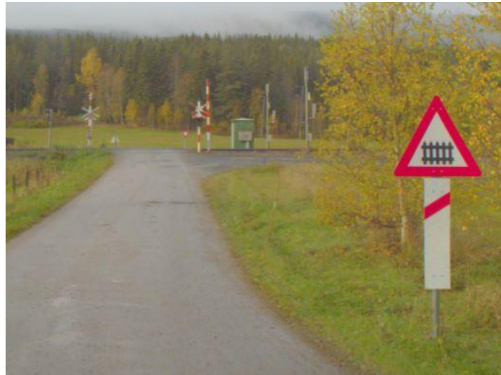
Jernbanekryssing fv. 2122 (Foto: Vegbilde fra Statens vegvesen)
