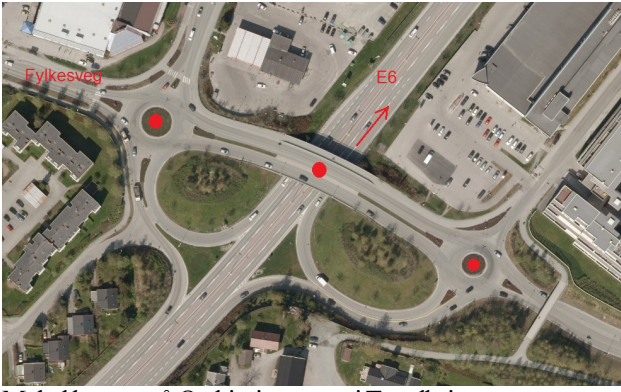
Moholtkrysset på Omkjøringsvegen i Trondheim
