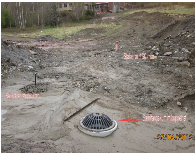
Sandfangskum, bakkekran og stakerør. Foto Terje Rønneberg
