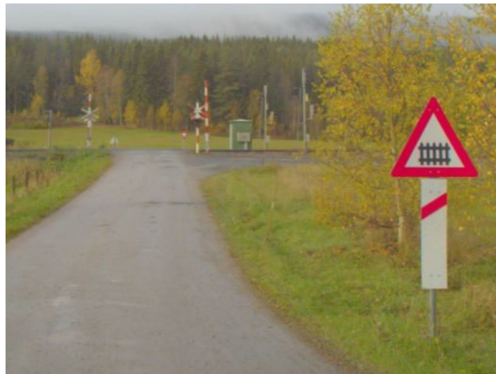
Jernbanekryssing fv. 2122 (Foto: Vegbilde fra Statens vegvesen)
