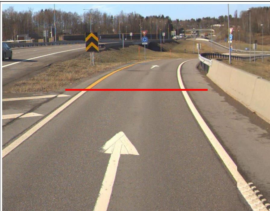
Figur 5, Foto: Statens vegvesen
