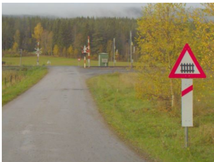
Jernbanekryssing fv. 2122 (Foto: Vegbilde fra Statens vegvesen)
