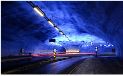
Lyssetting i Vallaviktunnelen. Foto Knut Opeide
