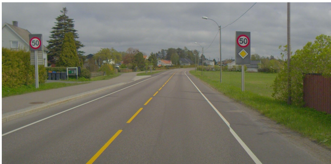
Fartsgrense (Foto: Vegbilder, Statens vegvesen)
