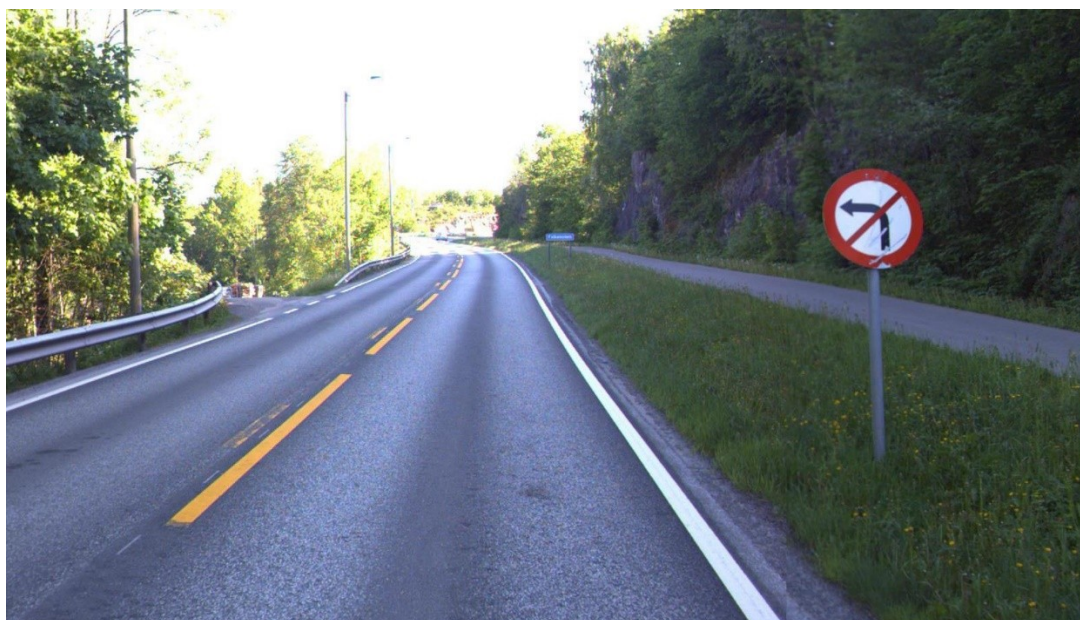
Figur 1 Svingerestriksjon (Foto: Statens vegvesen)
