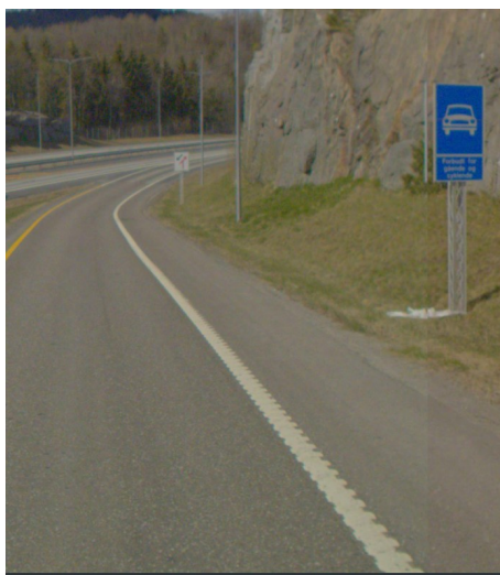
Påkjøringsrampe vestover. Foto: Vegbilder, Statens vegvesen
