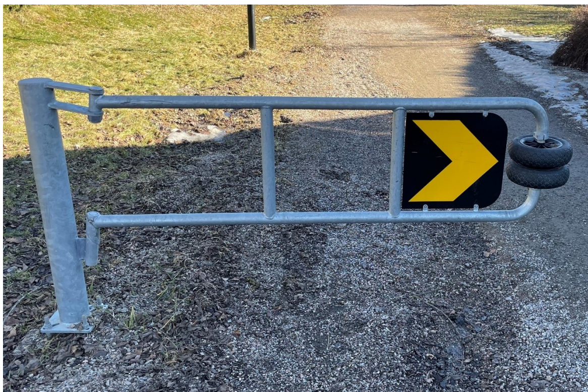
Figur 1 Vegsperring (Foto: Nikolaj Fyhn, Statens vegvesen)
