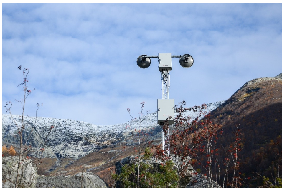
Figur 1 Skred, varsling/overvåkning (Foto: Vegard Bondevik Lie / Statens vegvesen)
