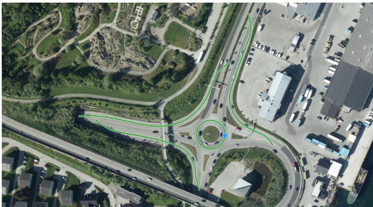
Figur 1 Kryssystem, her merket som blått punkt, bestående av rundkjøring og egne avkjøringsfelt for E8 i Tromsø. (Foto: Fra Vegkart)
