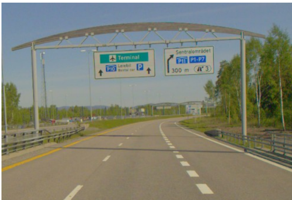
Skiltportal (Foto: Statens vegvesen)
