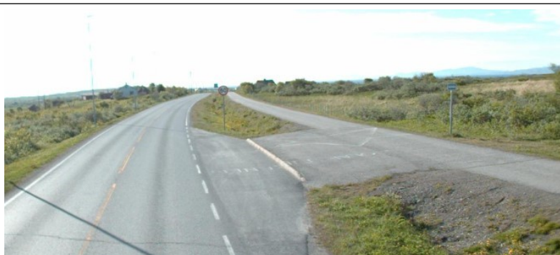
Foto: Vegbilde, Statens vegvesen
