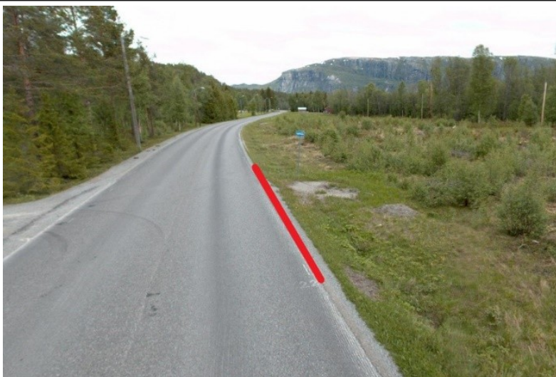
Foto: Vegbilde, Statens vegvesen
