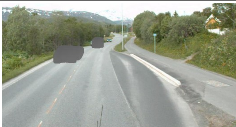
Foto: Vegbilde, Statens vegvesen
