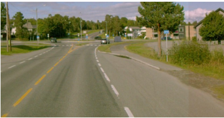
Foto: Vegbilde, Statens vegvesen
