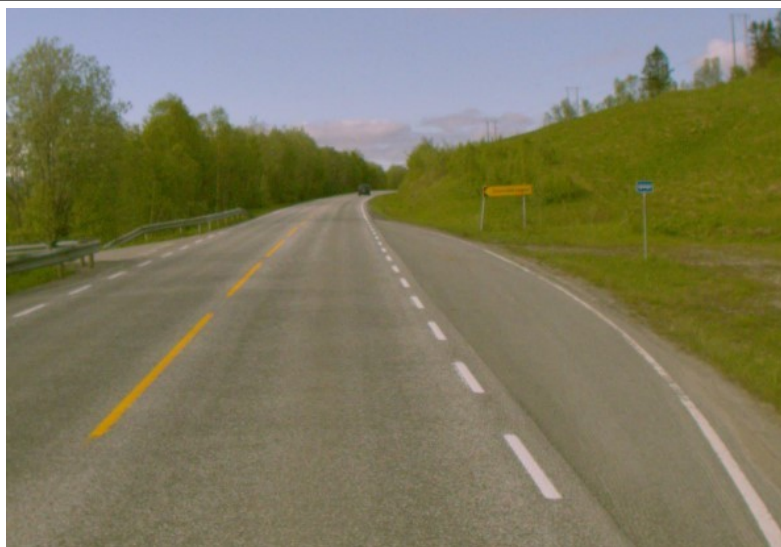
Foto: Vegbilde, Statens vegvesen
