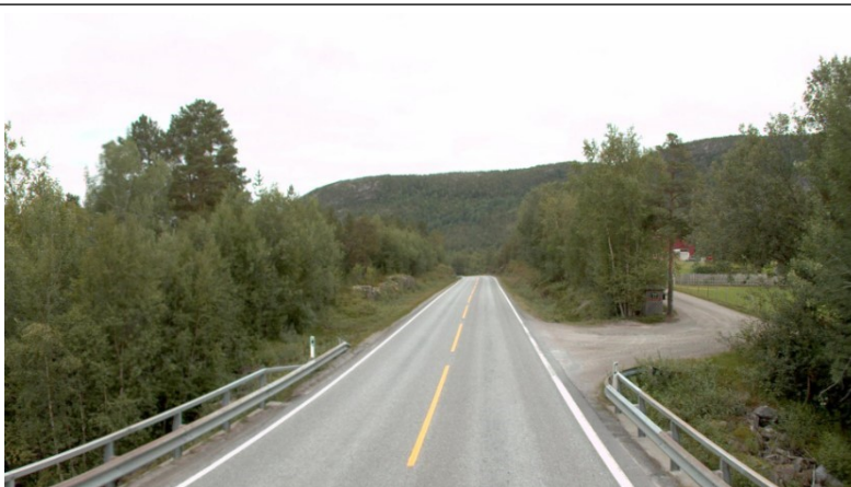
Foto: Vegbilde, Statens vegvesen
