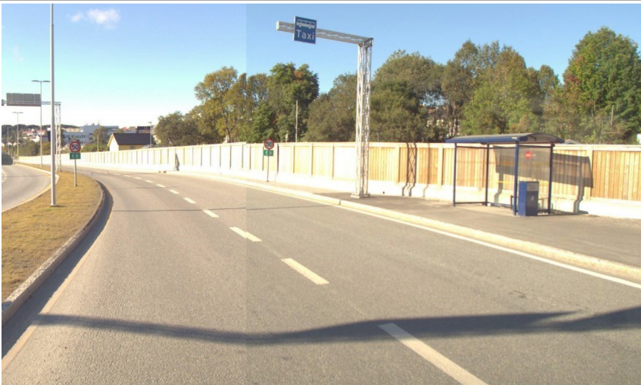
Foto: Vegbilde, Statens vegvesen
