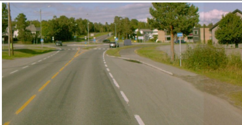
Foto: Vegbilde, Statens vegvesen
