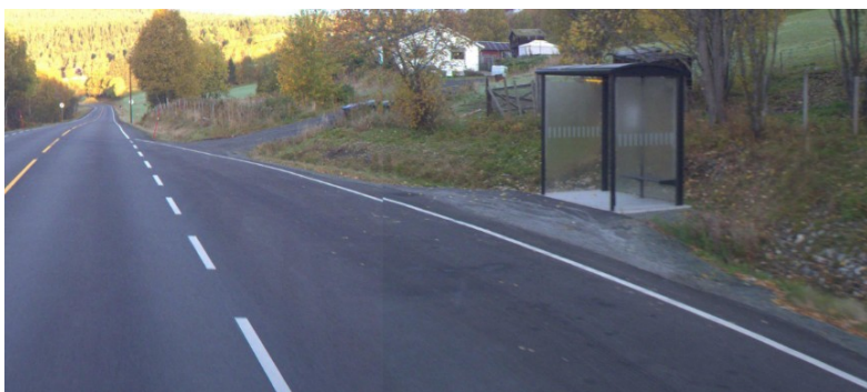
Foto: Vegbilde, Statens vegvesen
