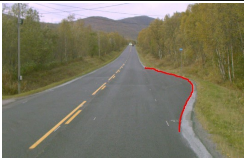
Foto: Vegbilde, Statens vegvesen
