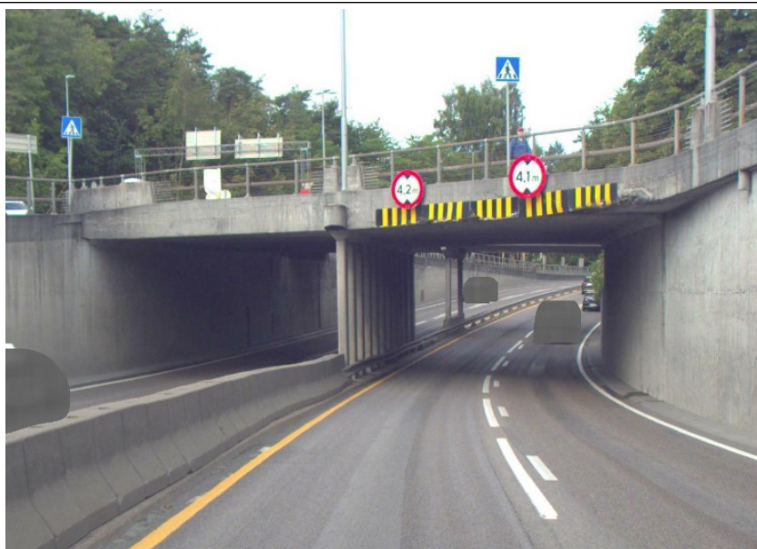
Retning mot Drammen, mot metreringsretning (felt 2 og 4)
