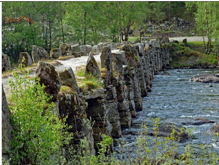
Foto: Geir Magnus Tunland, Statens vegvesen
