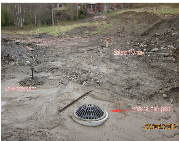
Sandfangskum, bakkekran og stakerør. Foto Terje Rønneberg
