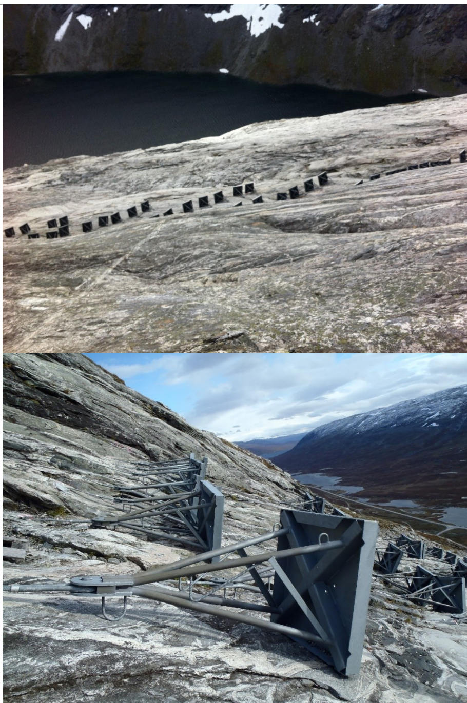
Foto: Halgeir Dahle, Statens vegvesen
