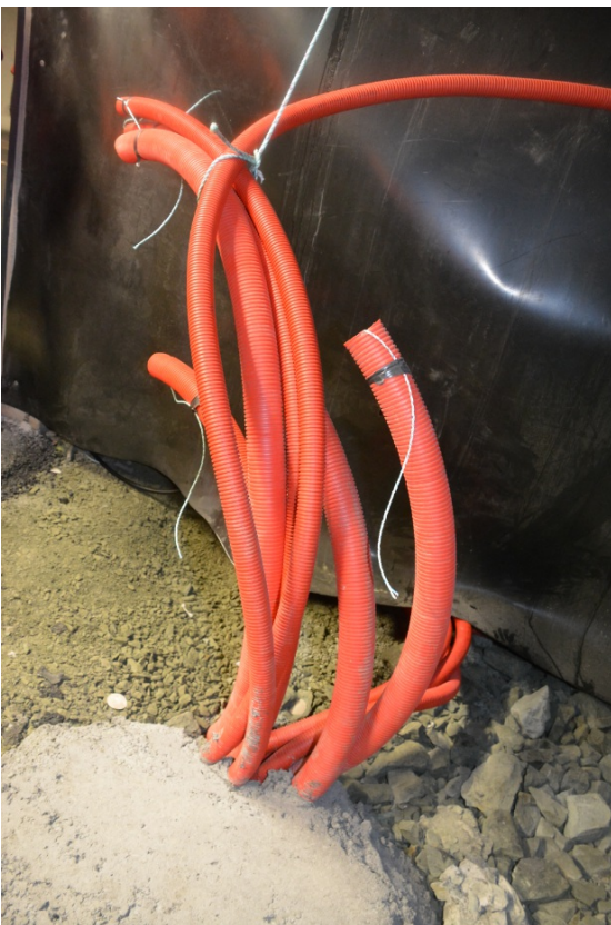
Trekkerør i bankett. Foto: Tore Paulsen
