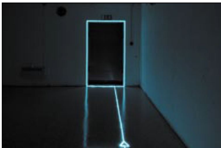
Lystråd som viser evakueringsvei via en dør. Foto: Lystech
