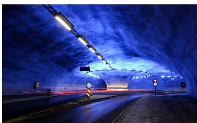
Lyssetting i Vallaviktunnelen. Foto Knut Opeide
