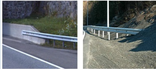
Sideforankring i mur og jordskjæring
