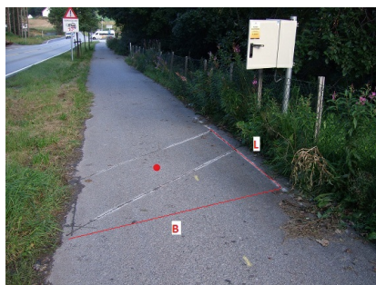
{Detektor, trafikk} med induktiv sløyfe for sykkel. Rødt punkt viser hvor geometri skal registreres
