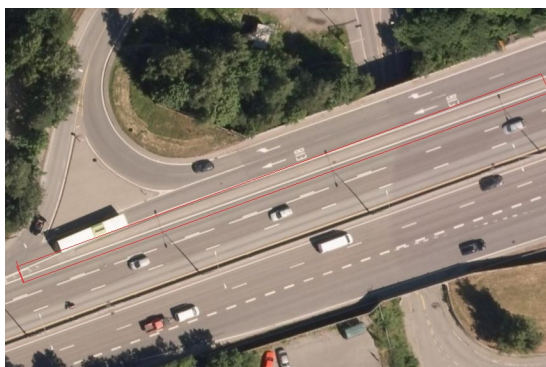
Trafikkdeler mellom paralelle strømmer. Foto: Norge i Bilder
