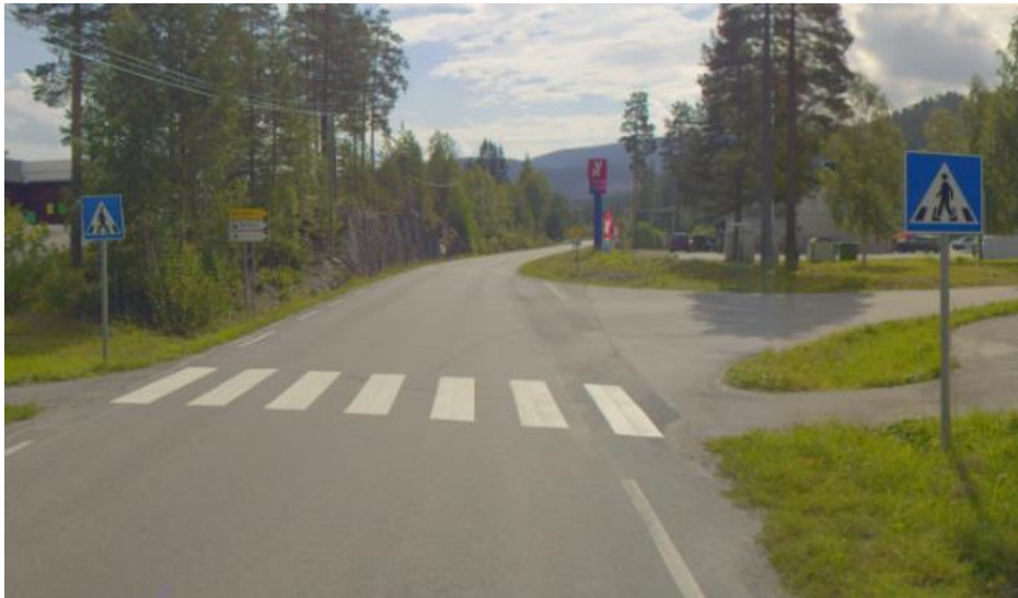
Figur 1 Gangfelt (Foto: Statens vegvesen/Innlandet fylkeskommune)
