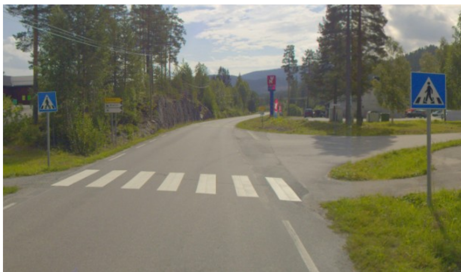
Figur 1 Gangfelt (Foto: Statens vegvesen/Innlandet fylkeskommune)
