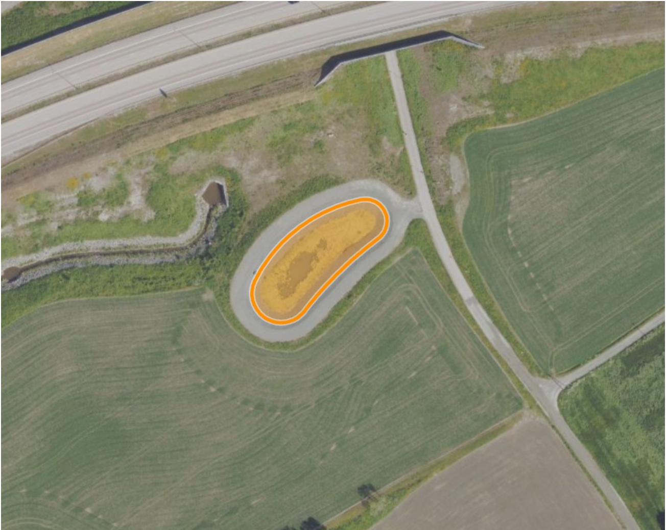
Figur 1 Basseng for rensing ved E6 i Trondheim (Foto: Fra Vegkart)
