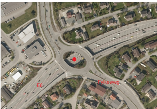
Nardokrysset på Omkjøringsvegen i Trondheim
