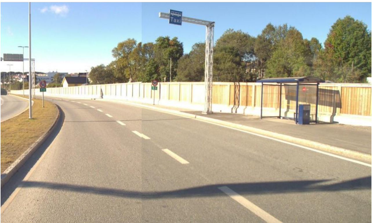
Foto: Vegbilde, Statens vegvesen
