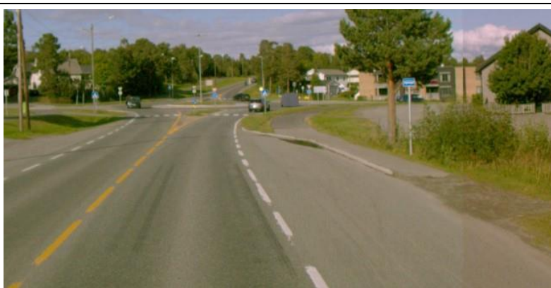
Foto: Vegbilde, Statens vegvesen
