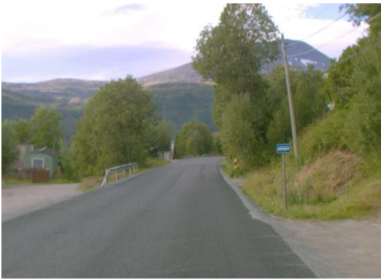
Foto: Vegbilde, Statens vegvesen
