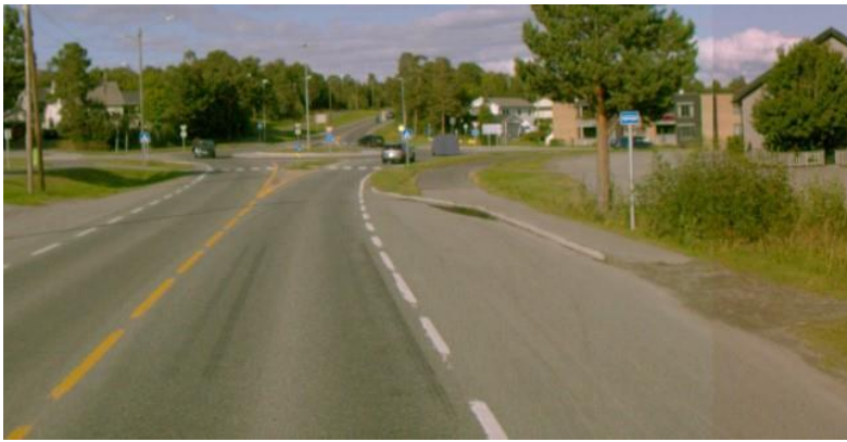
Foto: Vegbilde, Statens vegvesen
