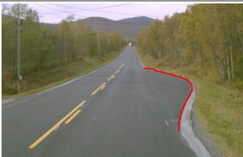
Foto: Vegbilde, Statens vegvesen
