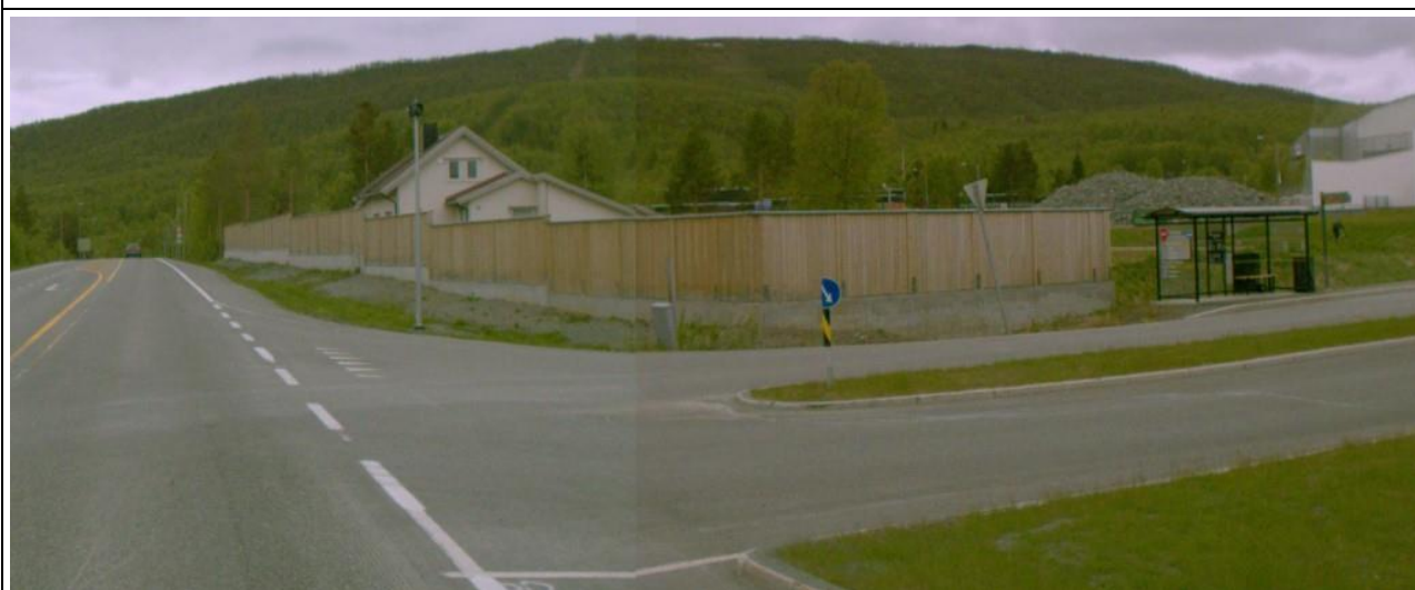
Foto: Vegbilde, Statens vegvesen
