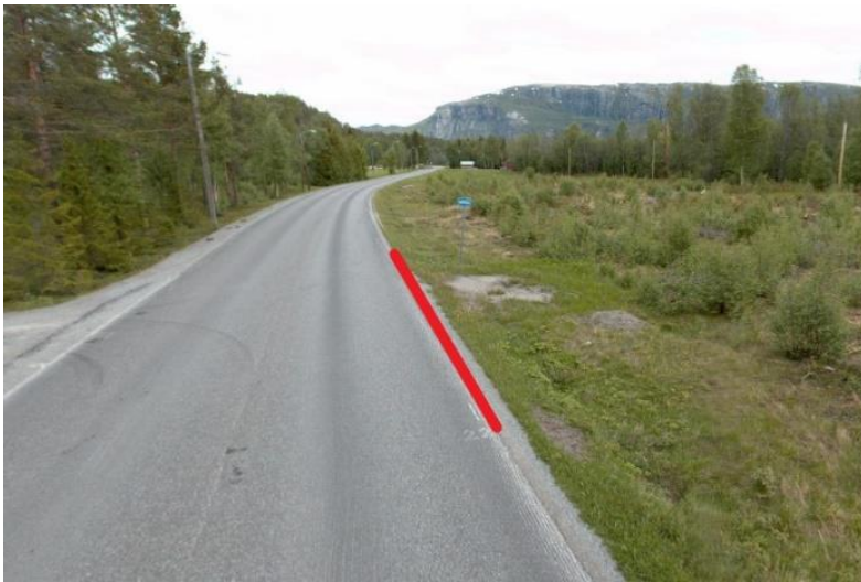
Foto: Vegbilde, Statens vegvesen
