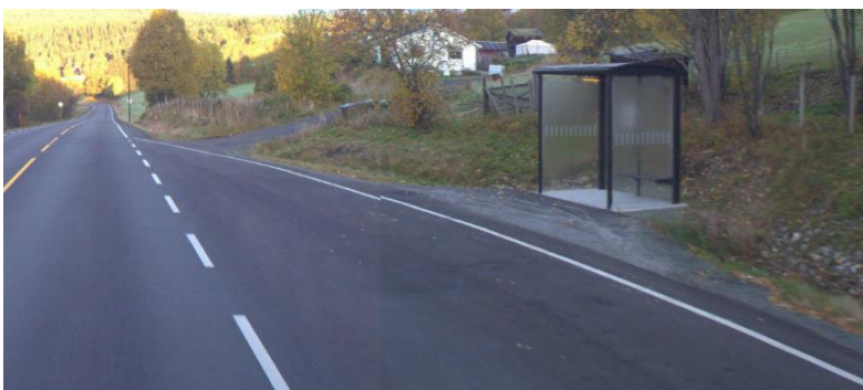
Foto: Vegbilde, Statens vegvesen
