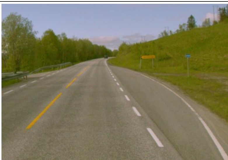
Foto: Vegbilde, Statens vegvesen
