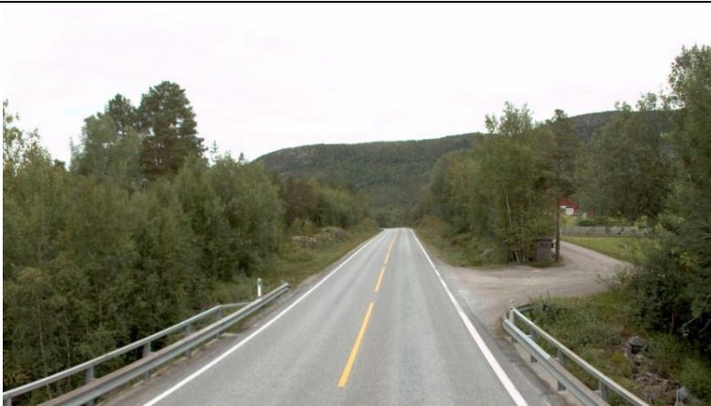
Foto: Vegbilde, Statens vegvesen
