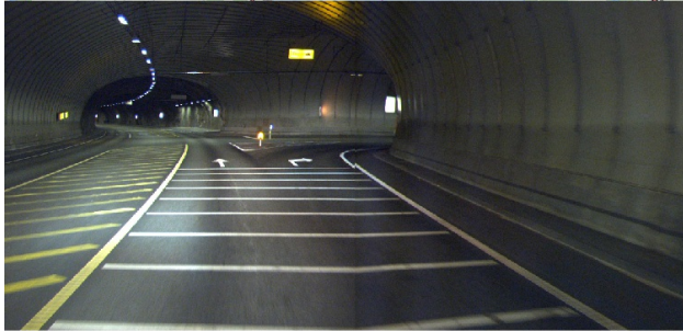
T-kryss i tunnel
