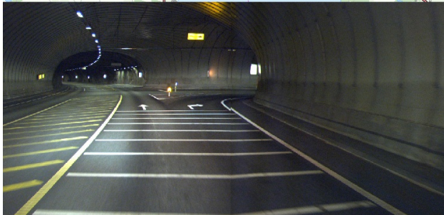
T-kryss i tunnel
