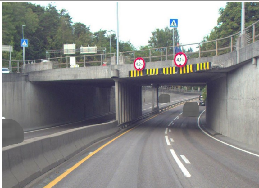
Retning mot Drammen, mot metreringsretning (felt 2 og 4)
