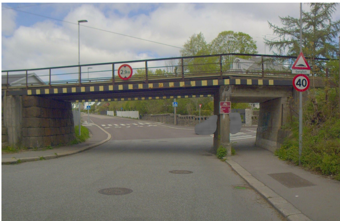
Figur 1 Høydebegrensning (Foto: Statens vegvesen/Vestfold og Telemark fylkeskommune)
