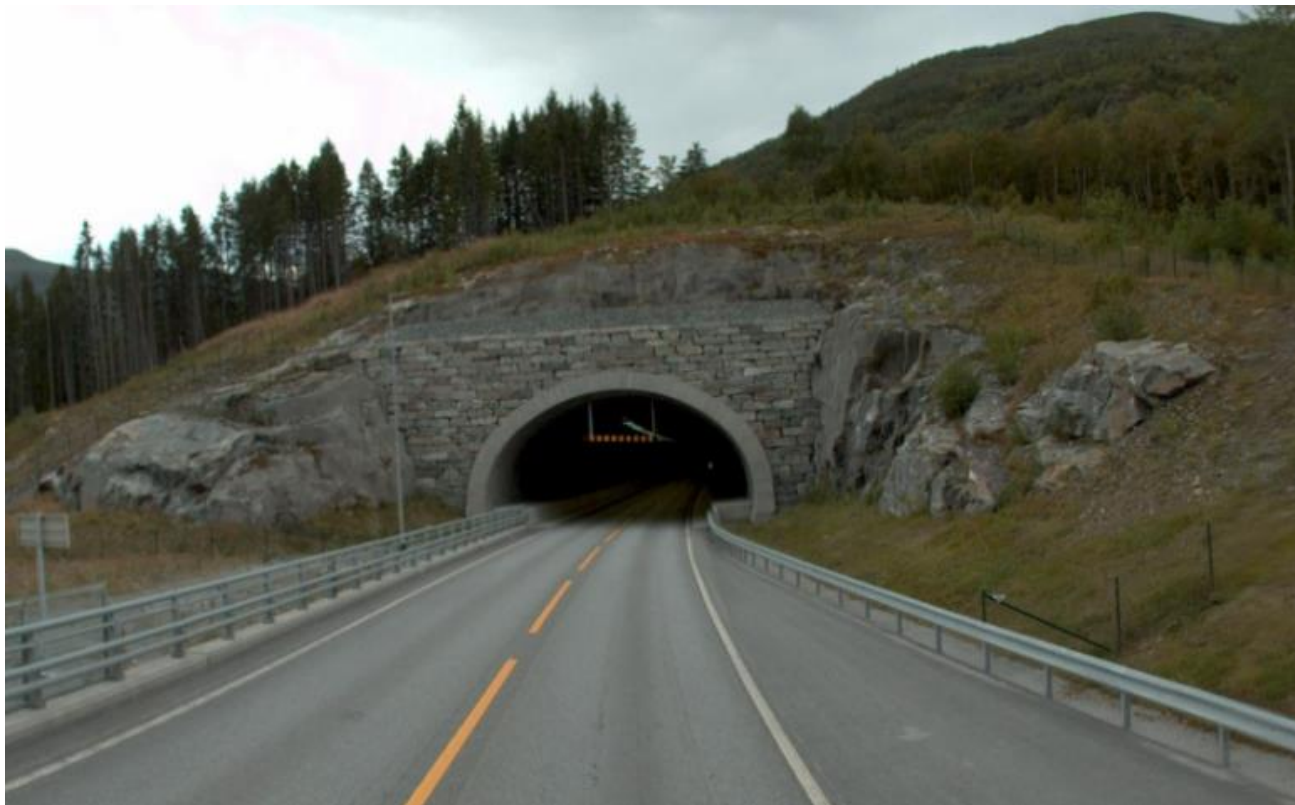
Figur 1 Tunnelportal E16 Rødølstunnel (Foto: Vegbilder, Statens vegvesen)
