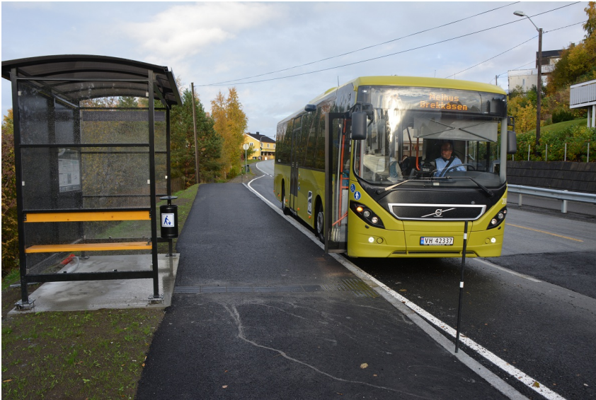
Figur 5: Eksempel på plattform ved busslomme (Hundhammeren i Malvik kommune). Foto: Tore Paulsen
