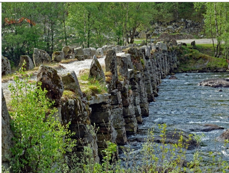
Foto: Geir Magnus Tunland, Statens vegvesen
