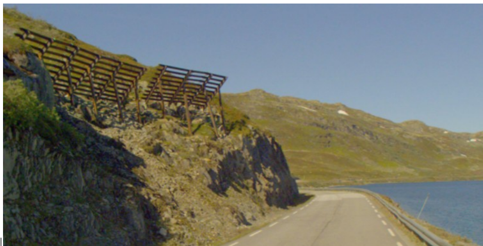
Figur 1 Støtteforbygning, snø (Foto: Vegbilder, Statens vegvesen)
