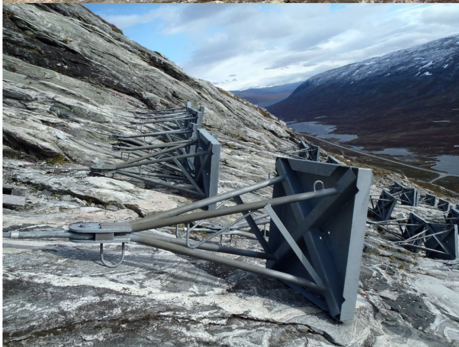
Foto: Halgeir Dahle, Statens vegvesen
