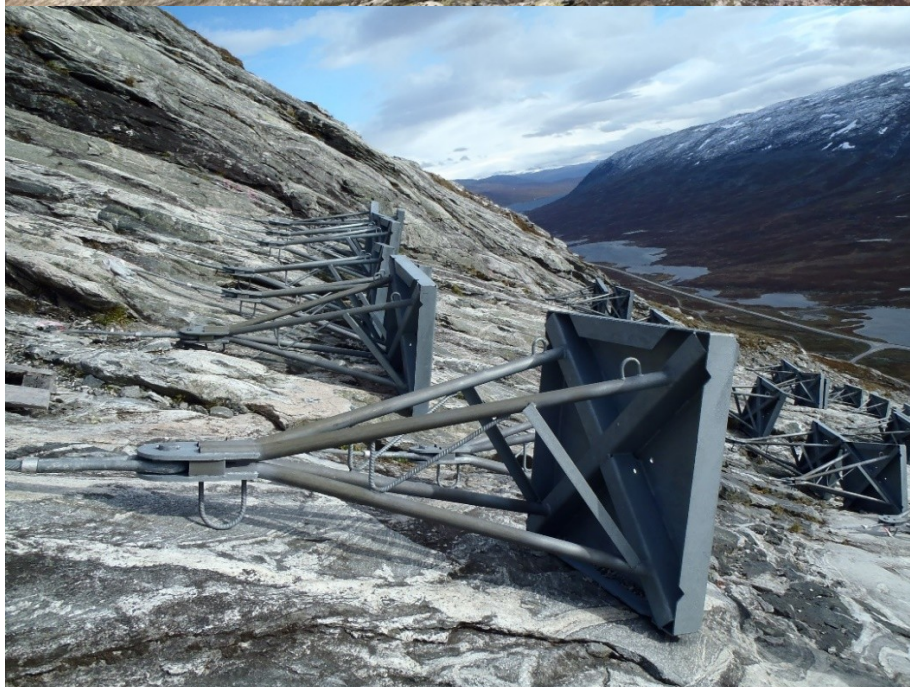
Foto: Halgeir Dahle, Statens vegvesen
