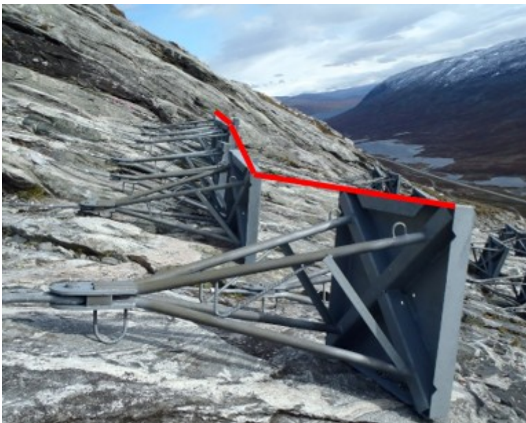
Foto: Halgeir Dahle, Statens vegvesen
