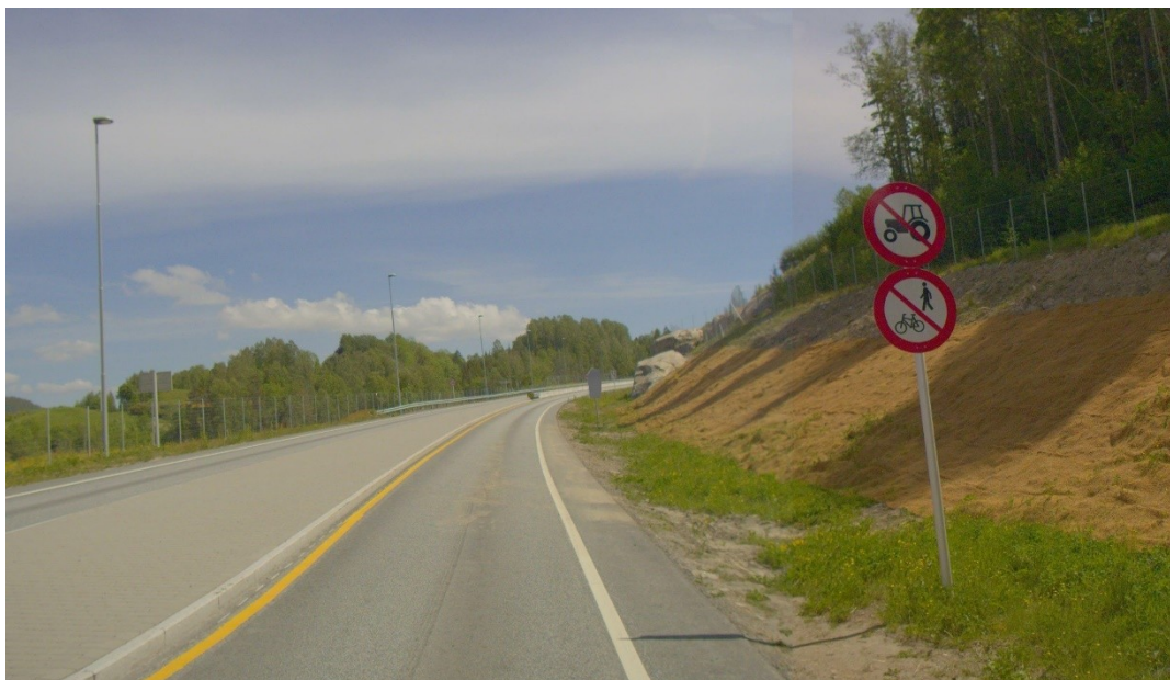
Figur 1 Trafikkreguleringer (Foto: Statens vegvesen)
