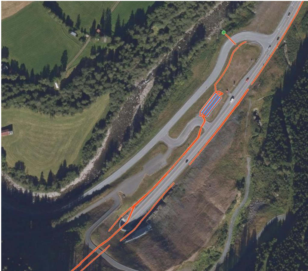
Figur 1 Vannhåndteringsanlegg ved Soknedalstunnelen på E6 i Trøndelag (Foto: vegkart.no)
