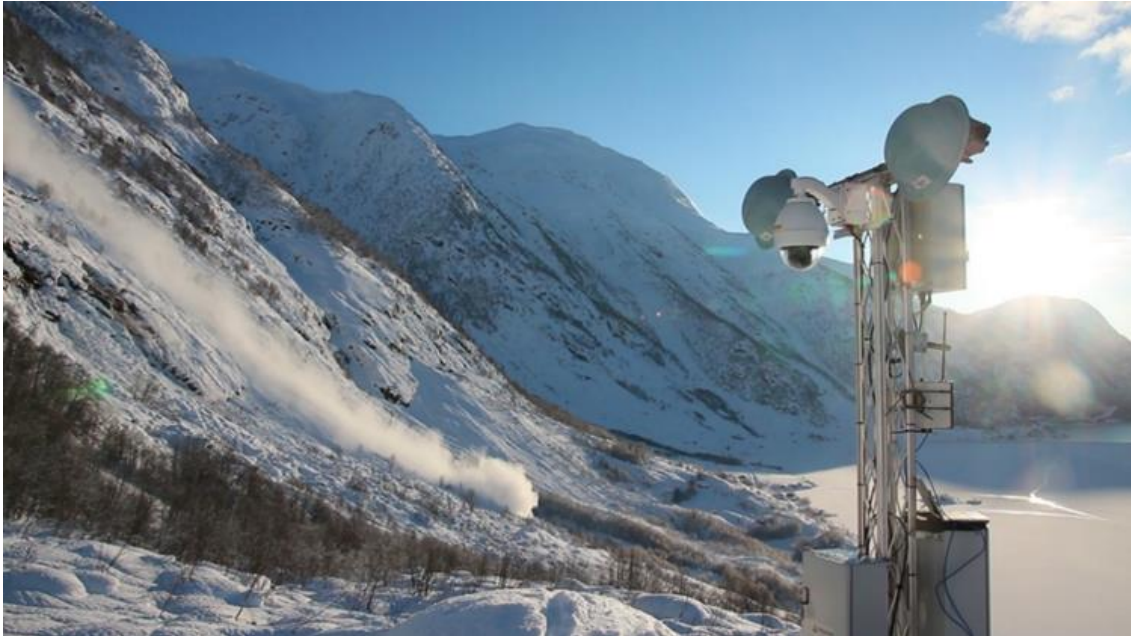
Figur 1 Skredteknisk objekt (Foto: Lars Krangnes, Cautus Geo)
