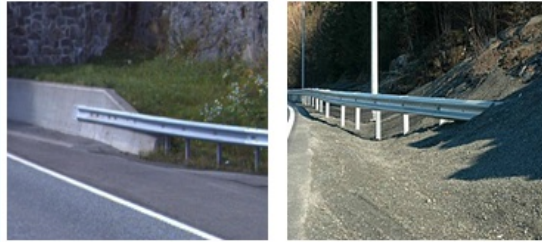
Sideforankring i mur og jordskjæring
