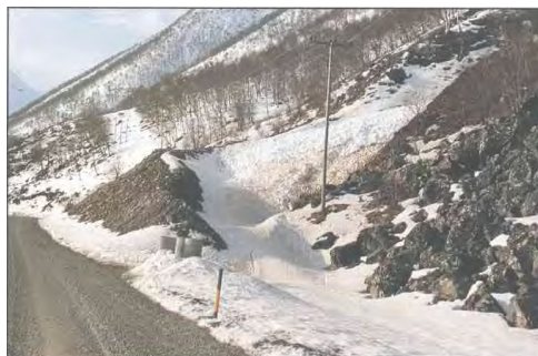
Figur 2.15 Ledevoller kan brukes som separate sikringstiltak ved å endre skredets retning parallelt med veien. (Foto: A. Hustad).
