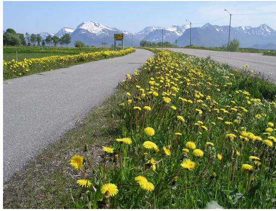
Vegstrekning med trafikkdeler mellom veg og GS-veg
