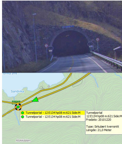
Tunnelportal på Åkrafjordtunnelen E134
