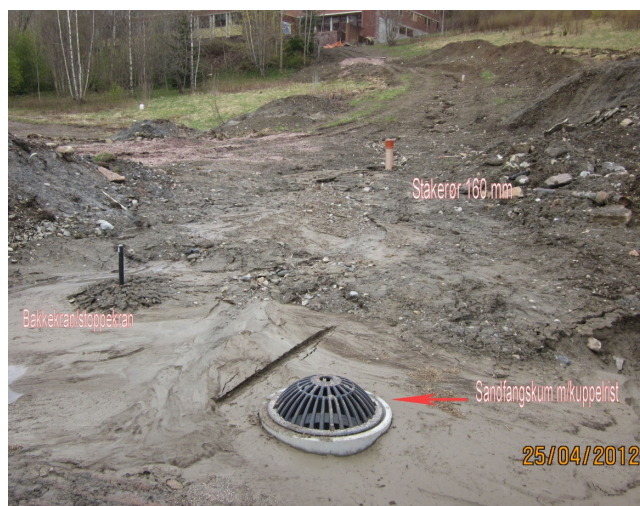
Sandfangskum, bakkekran og stakerør. Foto Terje Rønneberg
